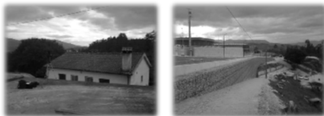
Figura 3 – Local de monitorização R2
