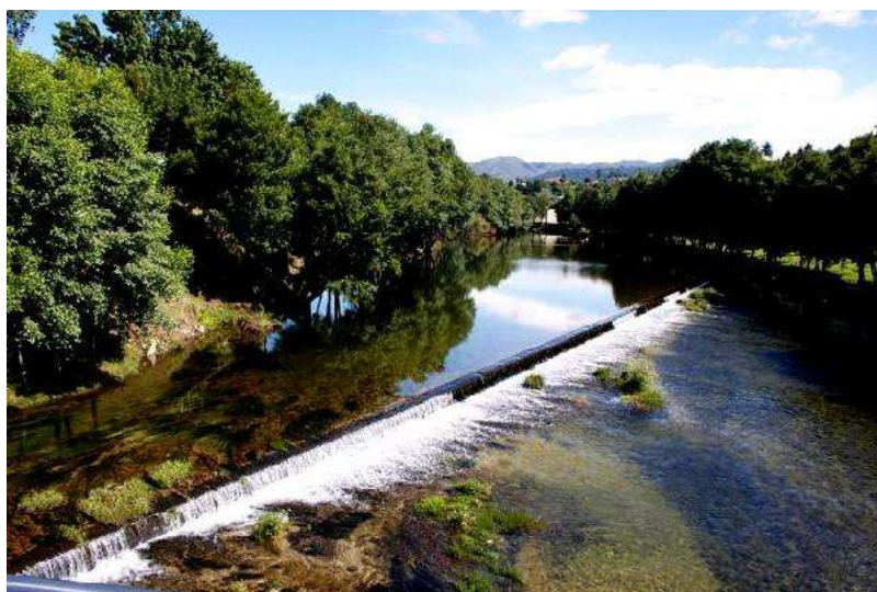
Figura 2 – Local de amostragem 1 (rio Vez, a montante da ETAR).
