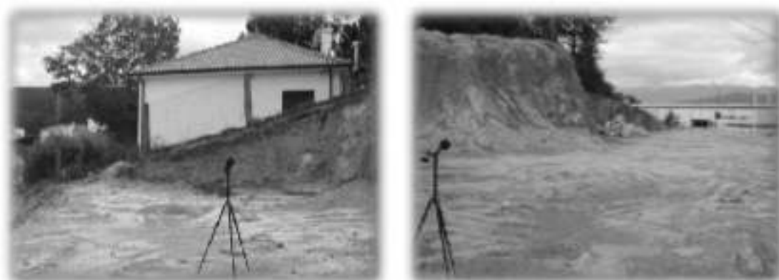
Figura 5- Local de monitorização R4
